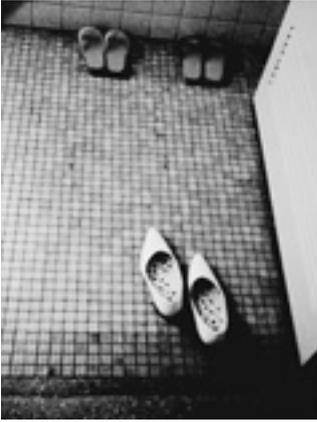
図3：トイレのドアが内開きであるため、スリッパが履きづらい状況
